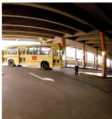
Piso inferior – Terminal central de ônibus urbano de Londrina
